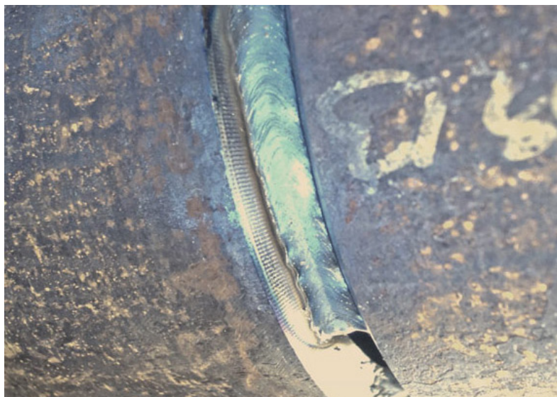
IAC - Vertikalno zavarivanje korjena od gore prema dolje na cijevima za grijanje. Brzina zavarivanja značajno povećana u odnosu na tradicionalno zavarivanje od dolje prema gore..
